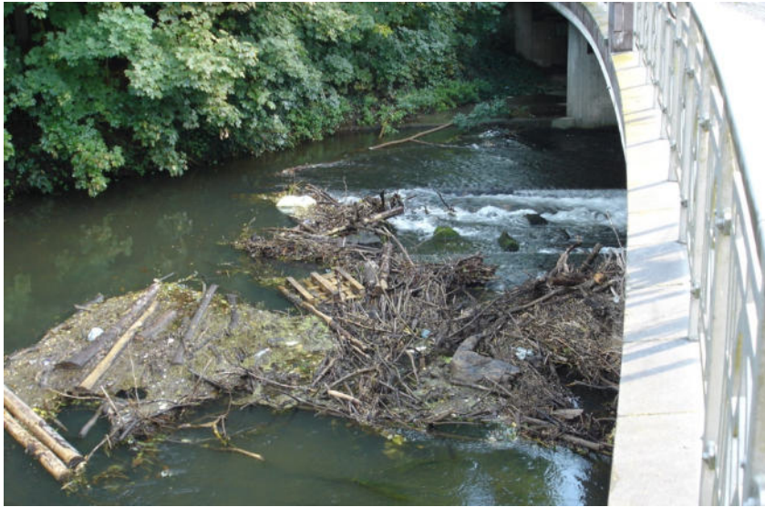
Der Ausstieg des Fischweges an der Kenosha-Brücke mit eingeschränkter Funktion (Foto Andreas Fischer 2017)
