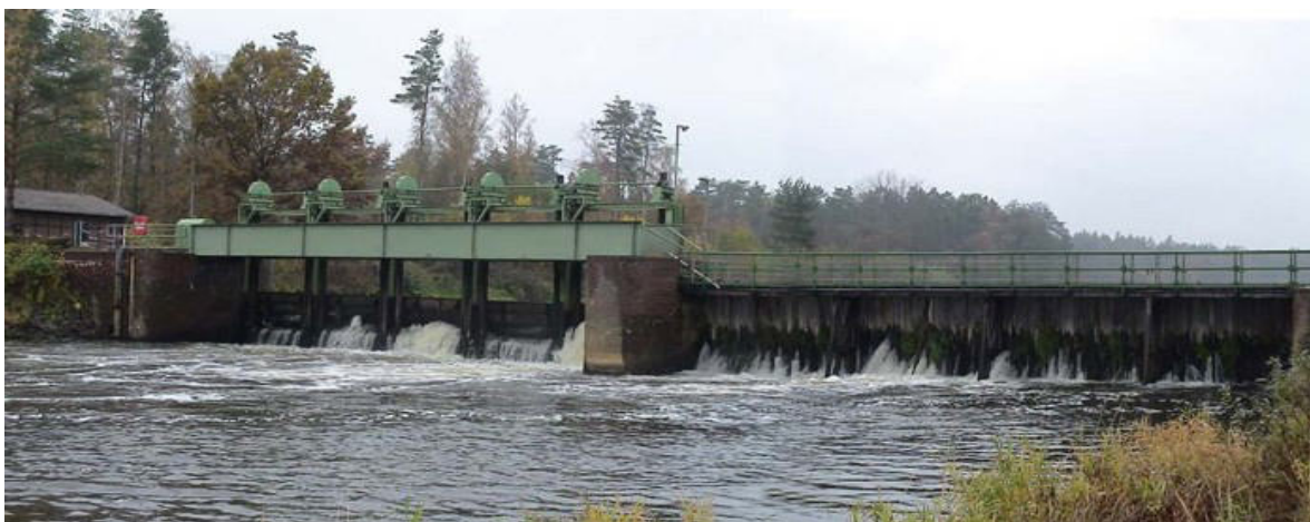
Das alte Nadelwehr in Bannetze vor dem Umbau (Foto Stefan Ludwig)
