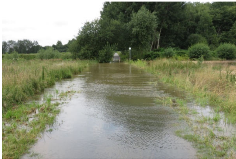
Brücke mit 2 Rohrdurchlässen am Bechtsbüttler Weg
