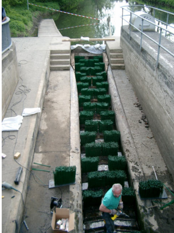
Installation des Borstenfischpasse s in Ölper. (Foto: Heiko Warnecke, NLKWN)
