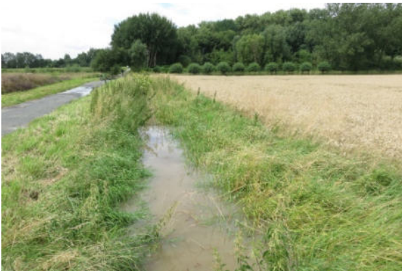
Rückstau im Quellgraben, der vor der Brücke am Bechtsbüttler Weg in den Beberbach mündet.
