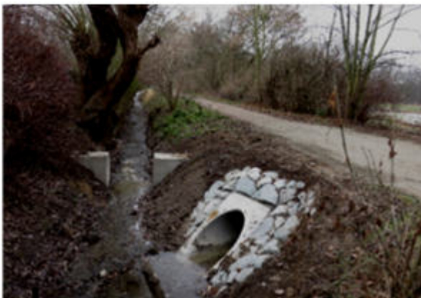
Neuer Durchlass am Vorflutgraben
