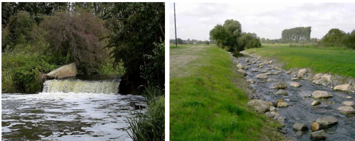
Bild links: Der Sohlabsturz in Hattorf 2004 und nach dem Umbau 2006 (Fotos Stefan Ludwig)
