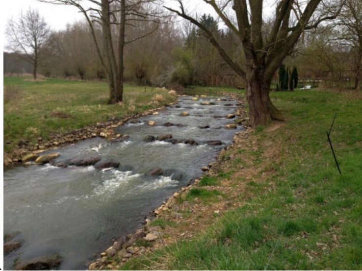
Der Raugerinne-Beckenpass in Glentorf - das meiste Wasser fließt über diesen Weg ab (Foto Stefan Ludwig 2015)
