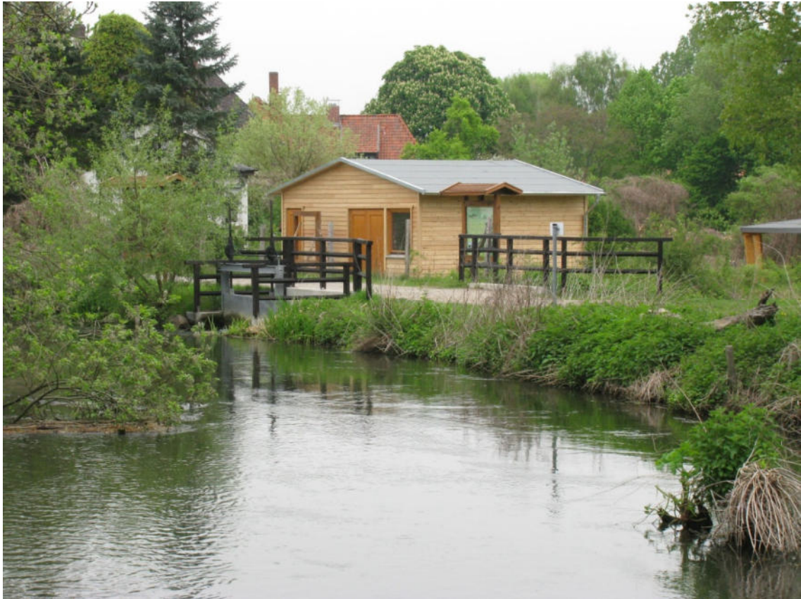
Der Aufbau des Info-Hauses wurde von der Firma Schenk an einem Tag erledigt. (Fotos Hans-Jürgen Sauer)
