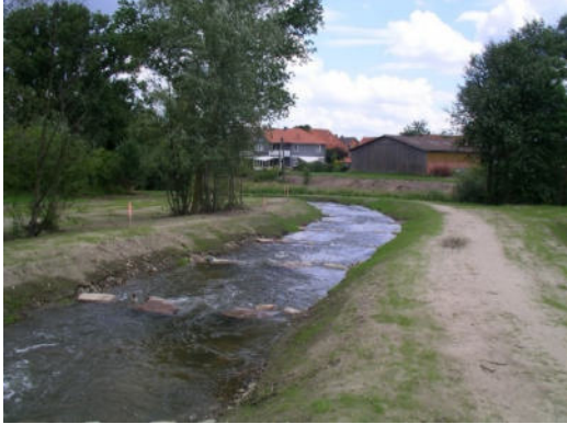
Umleitungsbach nach der Fertigstellung 2005
