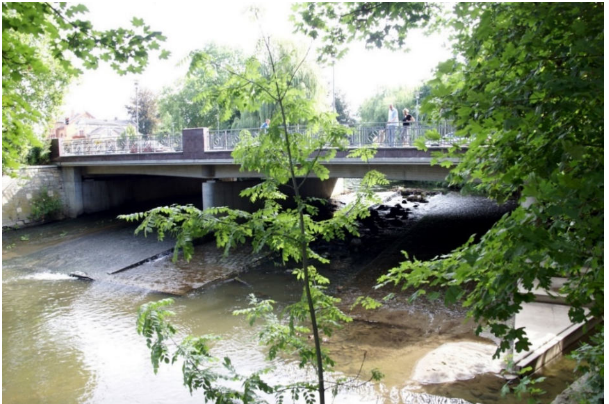
Die Kenosha-Brücke in Wolfenbüttel (Foto Stefan Ludwig 2010)
