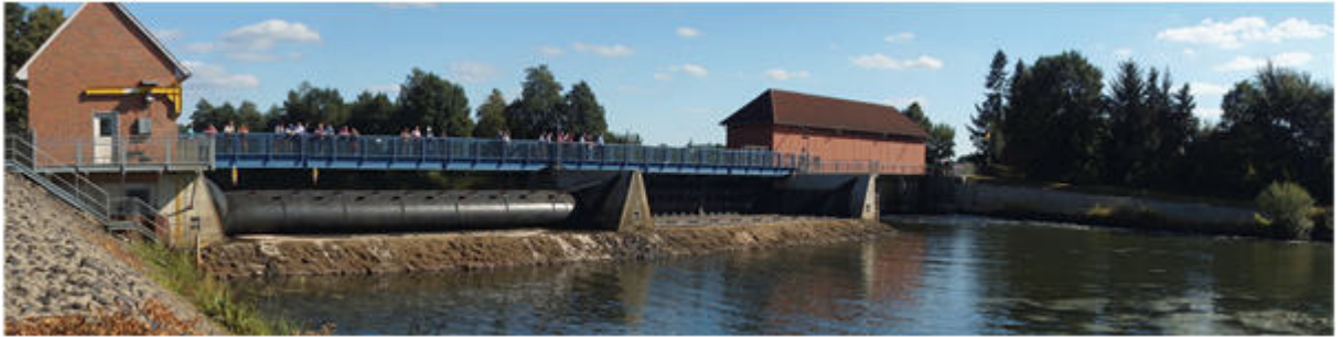
Foto: Marklendorf bei Niedrigwasser im August 2016 der komplette Abfluss geht durch die WKA (Foto Stefan Ludwig)
