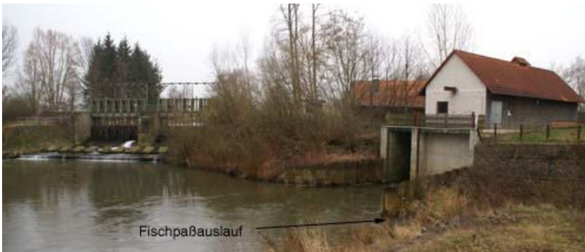
Die Wehr- und Wasserkraftanlage in Müden/Oker (Foto Stefan Ludwig)
