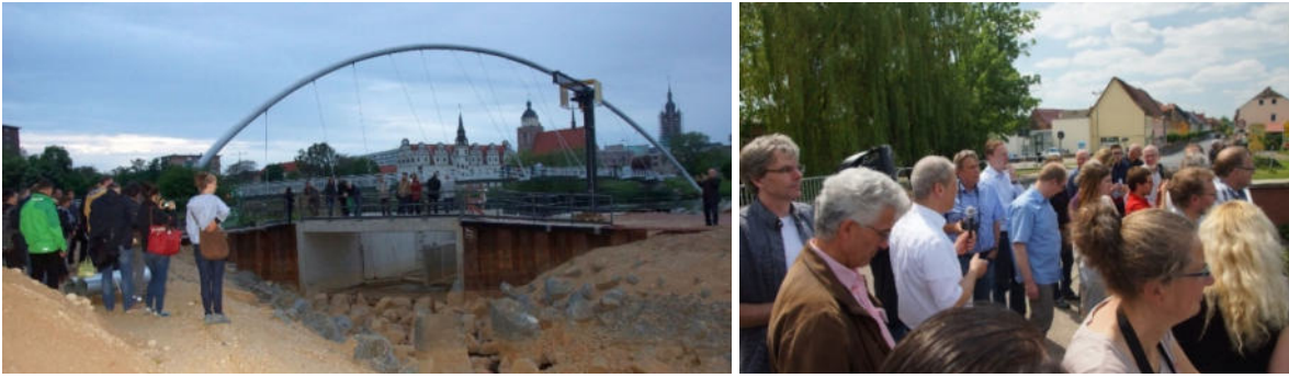
Links der neue Stör-taugliche Fischpass an der Mulde kurz vor der Eröffnung – rechts: Stephan Naumann erklärt die Fischschutzanlage in Raguhn/Mulde (Fotos Stefan Ludwig - 2017)
