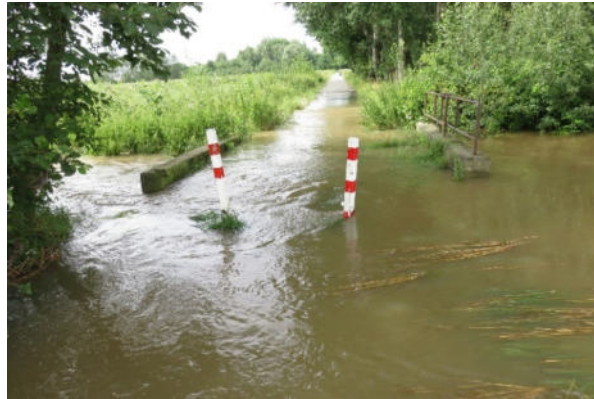
Obwohl ein zweiter Rohrdurchlass eingebaut wurde (2015), überflutete der Beberbach die Brücke am Bechtsbüttler Weg.
