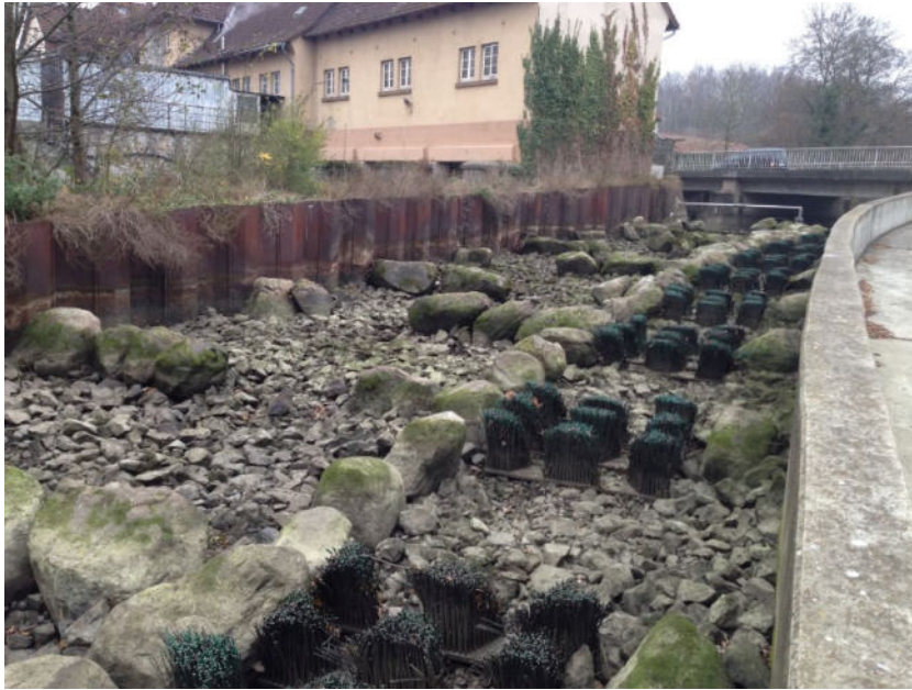
Der Fischpass während Wartungsarbeiten (Foto: Stefan Ludwig - 2014)
