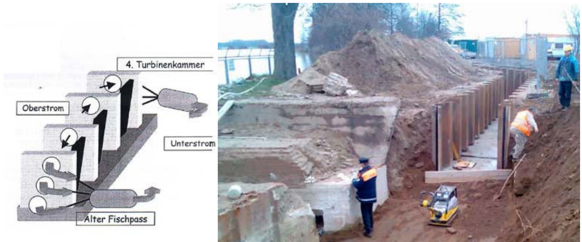
Bild und Foto: Planung der Fluchtröhre in Marklendorf und die Baustelle für den Fischpass (Foto Roland Freitag †)
