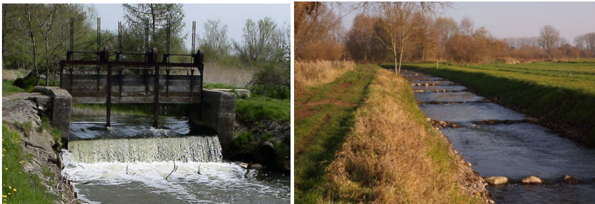
Die Wehranlage in Flechtorf vor dem Umbau (links) und danach (Fotos Stefan Ludwig)
