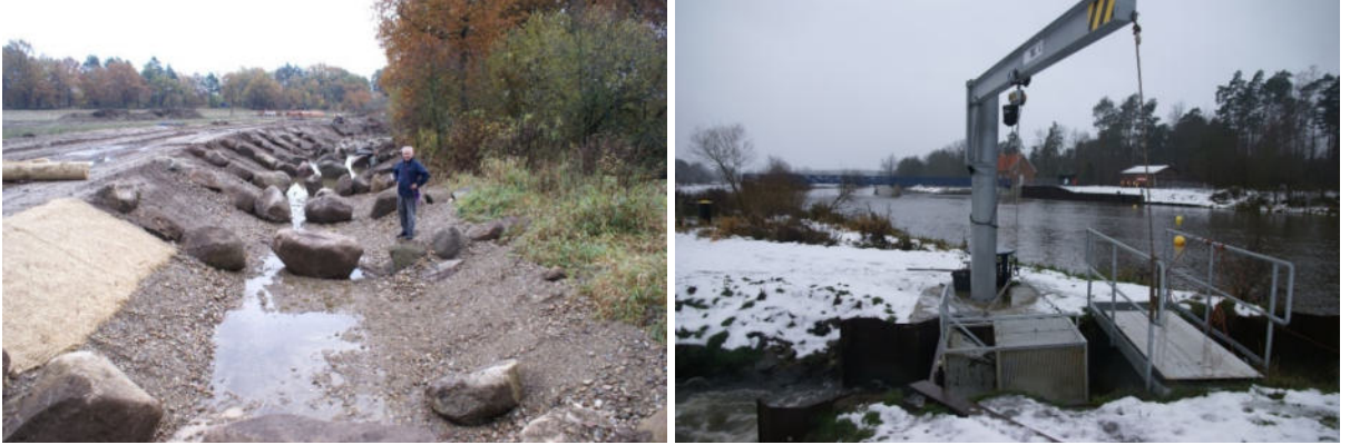
Der Fischpass in Bannetze kurz vor der Inbetriebnahme 2009 und während der Funktionüberprüfung 2010 (Fotos Stefan Ludwig)
