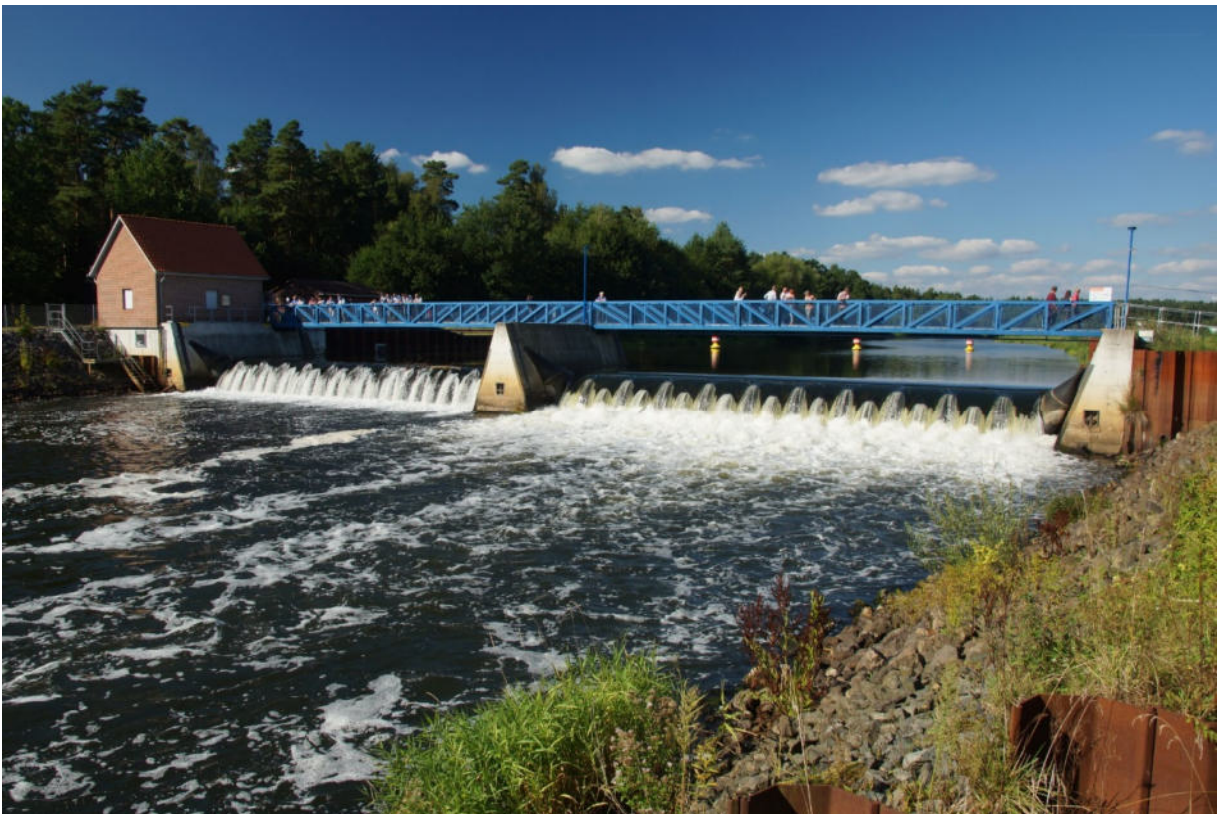
Das neue Schlauchwehr in Bannetze wie es seit 2009 in Betrieb ist (Foto Stefan Ludwig 2016)
