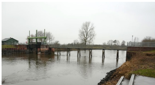
Abb.2 und 3: Das Wehr in Hademstorf links im Sommerstau unpassierbar für Fische. Rechts gelegte Nadeln im März 2023 für alle Fische frei passierbar
