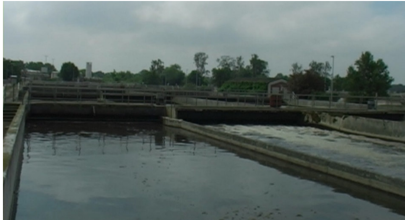
Die Braunschweiger Kläranlage Steinhof
