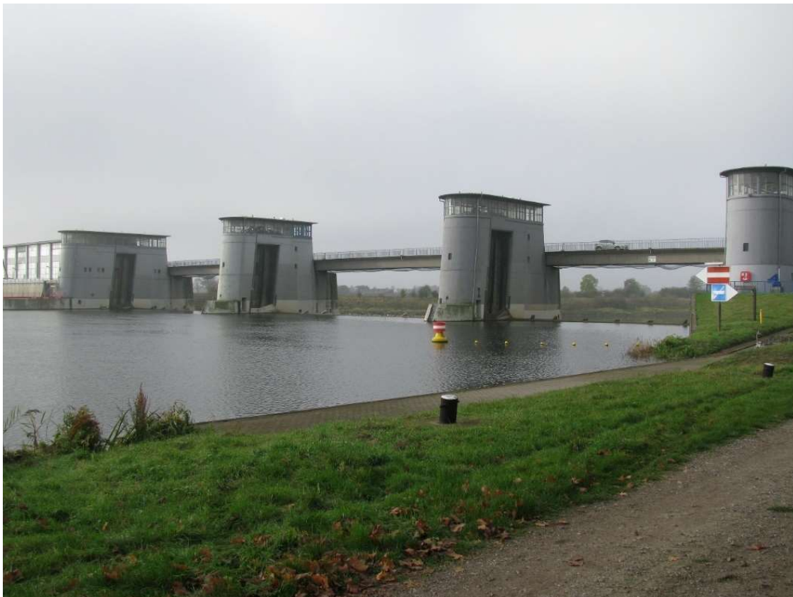
Kraftwerkswehr in der Weser bei Langwedel/Intschede
