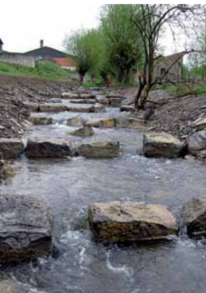
Beseitigung einer Wehranlage an der Brucht vor und nach dem Umbau
